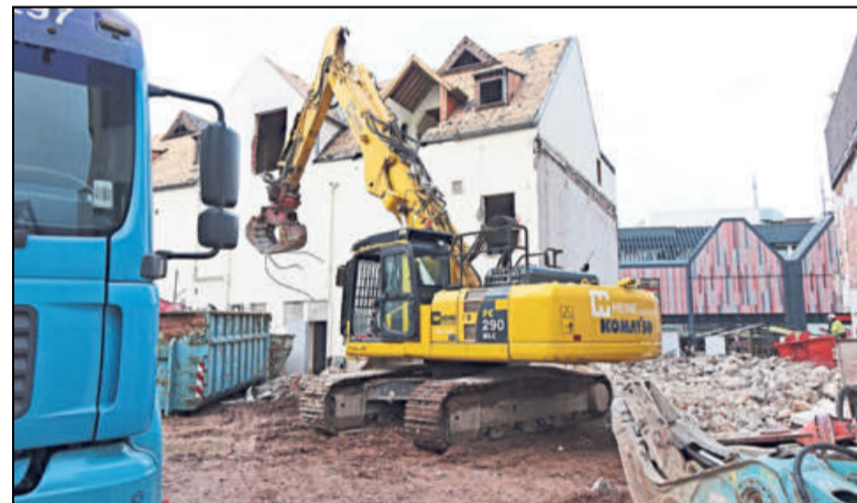
Freier Durchblick auf das Kaufhaus: Von der Rückseite aus zerlegt der Spezialbagger der Firma Heine Stück für Stück das Gebäude.
